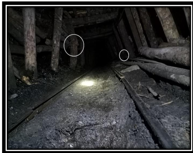
Gambar 22. Beberapa tiang yang patah dan lapuk
