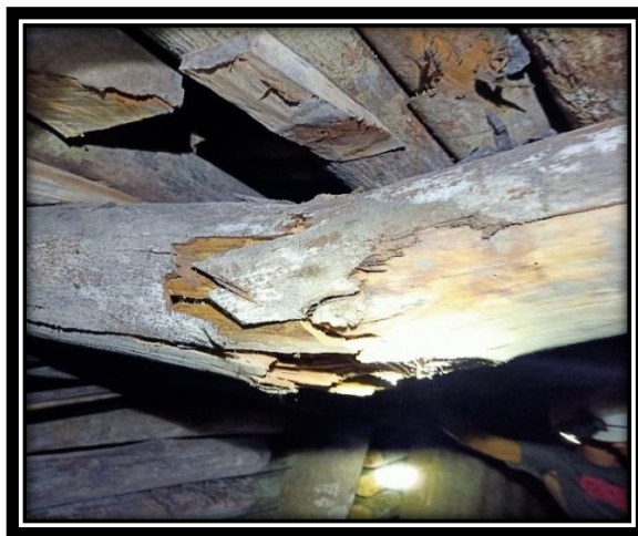
Gambar 21. Cap patah
