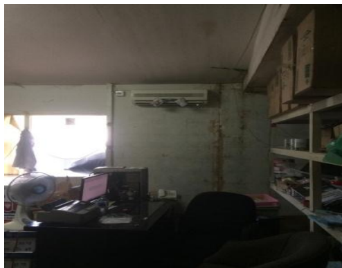
Gambar 4. Ruangan Kerja Store
