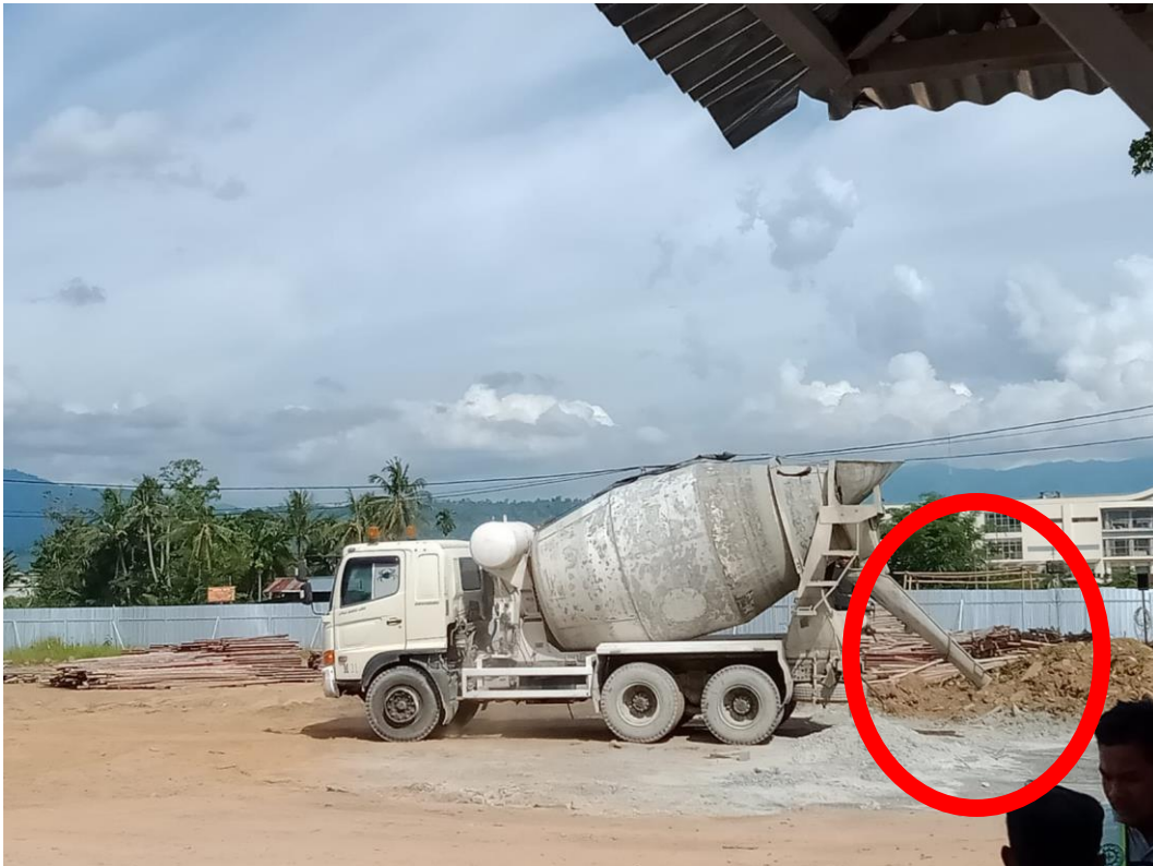
Pembuangan sisa semen truck mixer di area proyek
