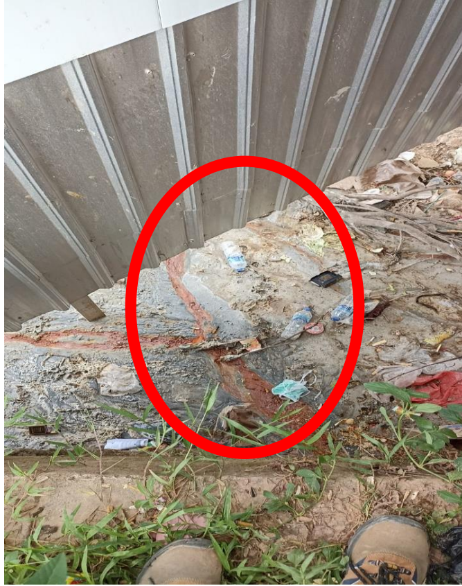
Sisa semen yang dibuang di area proyek mengeras dan menyumbat aliran air irigasi
