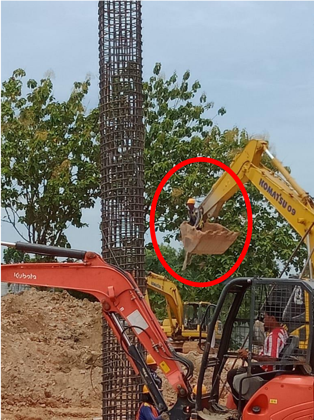
Pekerja turun dari ketinggian menggunakan bucket excavator
