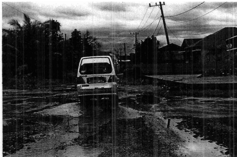
Gambar 6 : Kondisi jalan yang rusak karena saluran draenase yang tidak berfungsi pada Dataran Banjir DAS Batang Air Dingin
