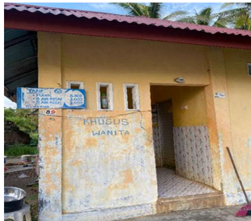
Gambar 5. WC Umum Pantai Arta Sumber: Dokumentasi Pribadi
