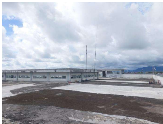
Gambar 2. Shelter Pada Bangunan SMA Yayasan Pembangunan Padang (Sumber: Dokumen Pribadi, 2023)
