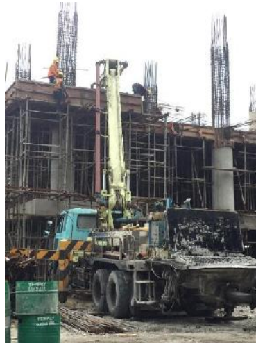
Gambar 1. Concrete Pump (Sumber: Dokumentasi Pribadi, 2023)
