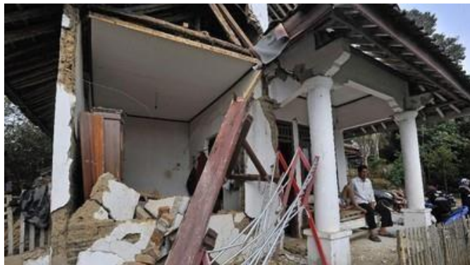
Gambar 1 Kerusakan Dinding Bata Akibat Gempa di Banten (2019) Sumber : Website CNN Indonesia
