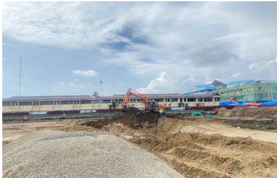
Gambar 1. Lokasi Proyek Pembangunan Pasar Raya Kota Padang Sumber: Data Lapangan, 2023
