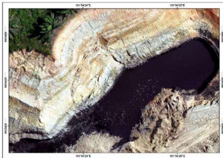
Gambar 1. Kondisi lereng longsor pada area Blok A PT PIR.
