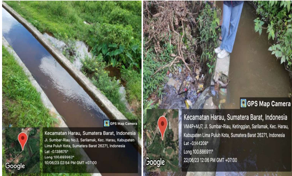
Gambar 2. Jaringan Irigasi Sanipan 2 (Sumber: Dokumentasi Pribadi, 2023)
