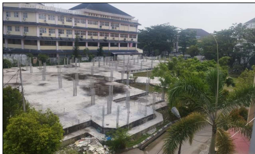
Gambar 6. Kondisi Terkini Gedung PPs FE UNP (Sumber: Dokumenn Pribadi, 2023)
