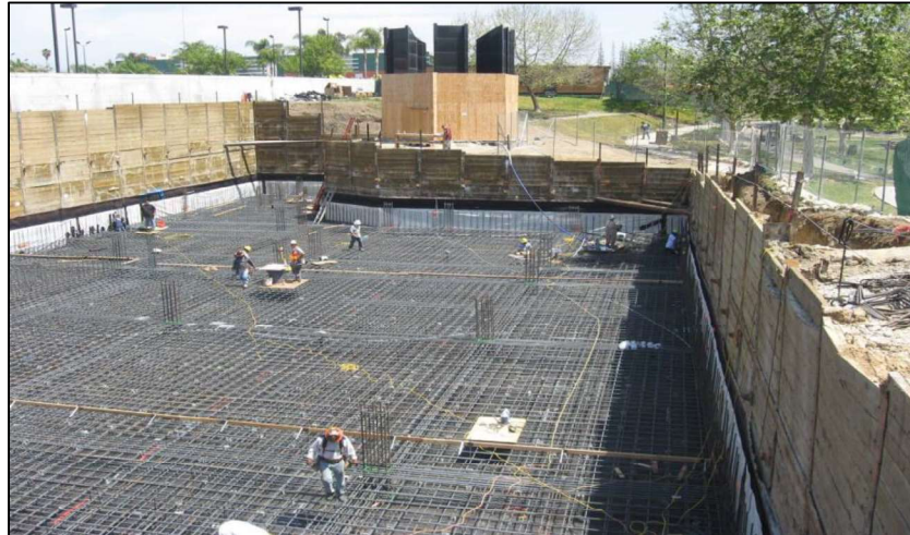
Gambar 4. Contoh Pengerjaan Pondasi Rakit (Sumber: Alo feat Prima, 2012)
