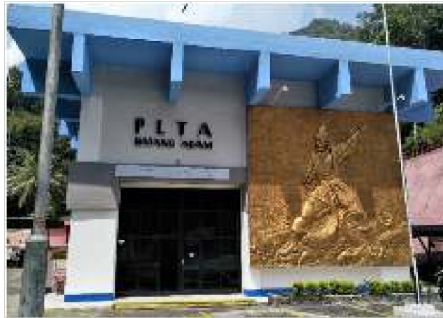
Gambar 2.1 Bangunan PLTA Batang Agam
