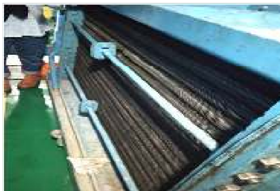
Gambar 4.3 Air Cooler PLTA Batang Agam
