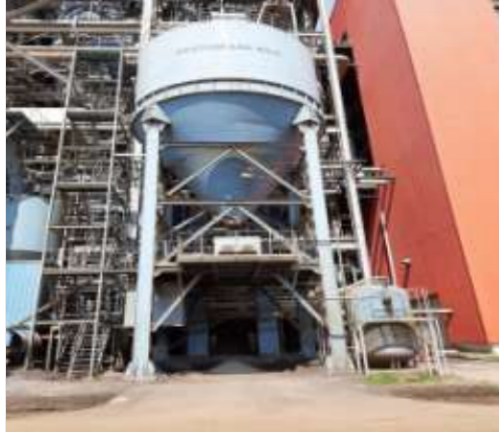
Gambar 19. Bottom Ash Silo
