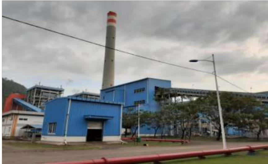
Gambar 1. Profil PLTU TELUK SIRIH
