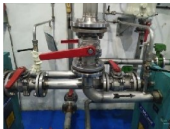
Gambar 4.2.1 Mengunci atau menutup arah aliran pada control calce
