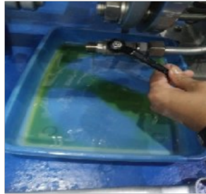
Gambar 4.2.2 mengeluarkan oli dan air yang tersisa pada Plate Heat Exchanger (PHE)
