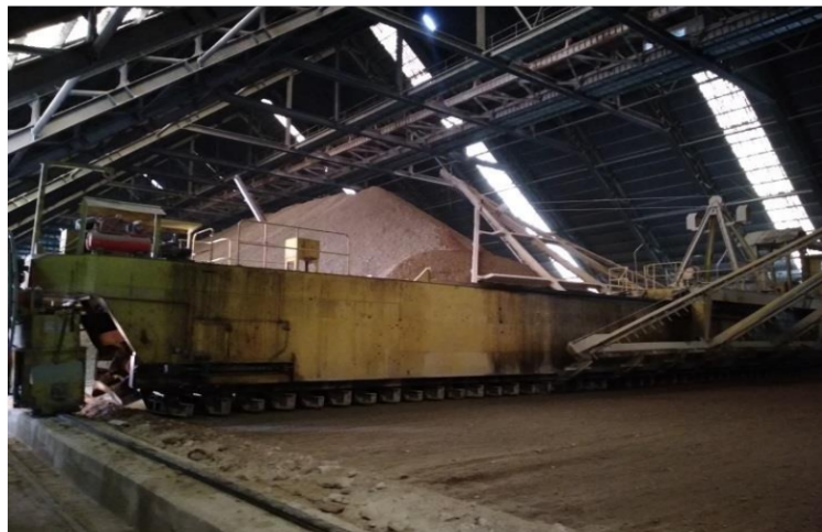
Gambar 30. Main girder (Sumber : Dokumentasi Pribadi)
