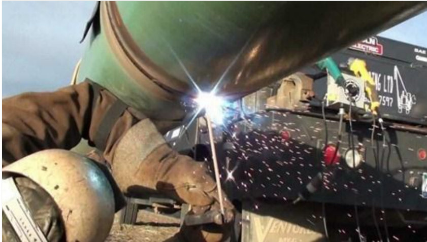
Gambar 3.20. Pengelasan SMAW adalah contoh pengelasan busur listrik
