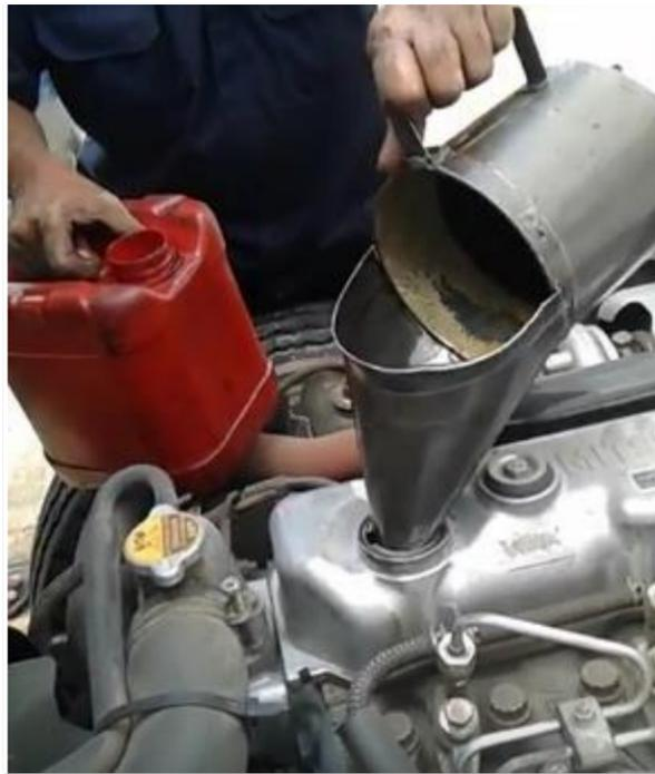
Gambar 2.3 Penambahan oli pada mesin crusher
