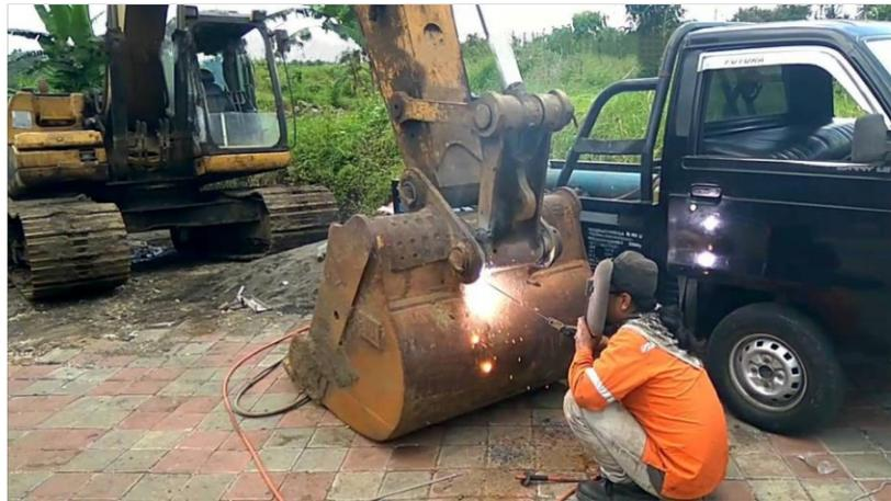
Gambar 2.6 kerusakan pada alat keruk (bucket)
