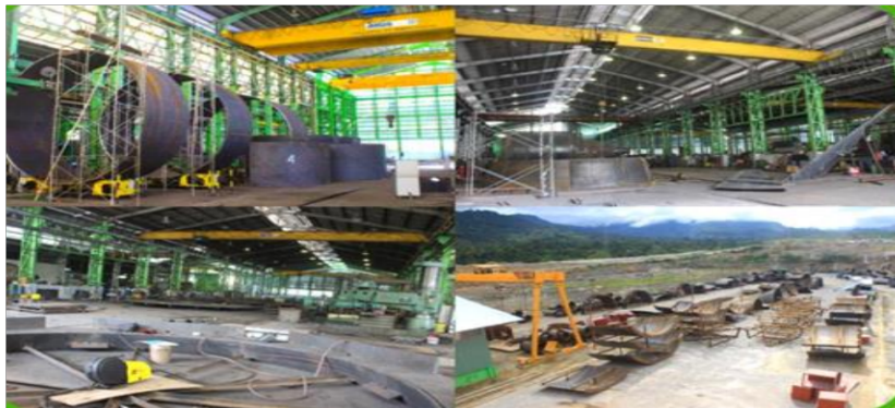
Gambar 2. 6. Area kerja pabrikasi workshop dan siteshop
