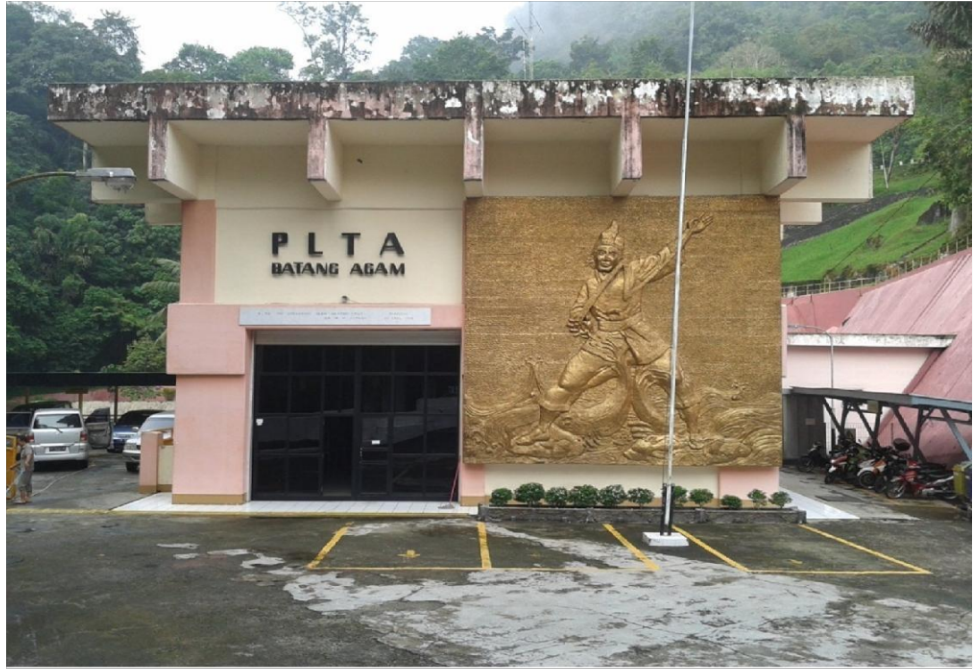
Gambar 1.1. Bagunan Power House PLTA Batang Agam
