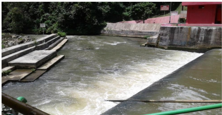
Gambar 1.10. Tail Race PLTA Batang Agam
