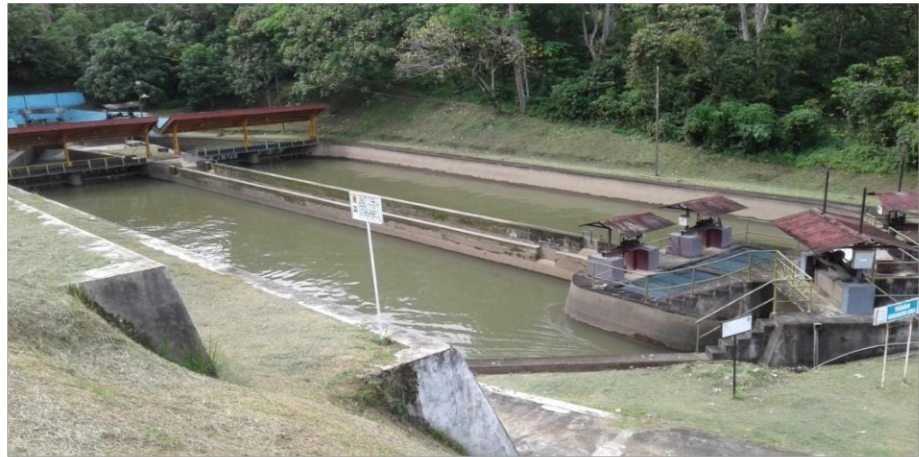
Gambar 1.3. sand trap PLTA Batang Agam
