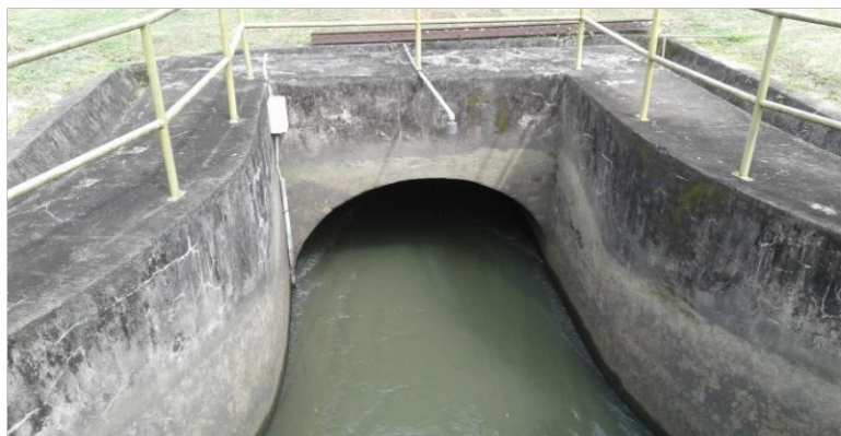
Gambar 1.4. tunnel II PLTA Batang Agam
