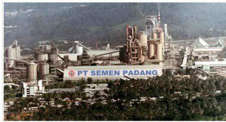
Gambar 1. 1 Pabrik PT. Semen Padang (Sumber : PT. Semen Padang)
