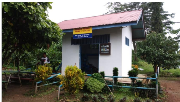
Gambar 2.28 Rumah Pompa Land Aplikasi
