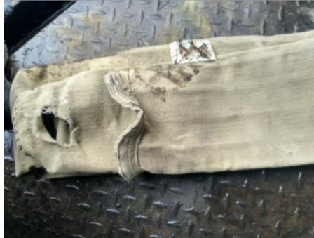
Gambar 4.12 Kebocoran pada Bag Filter
