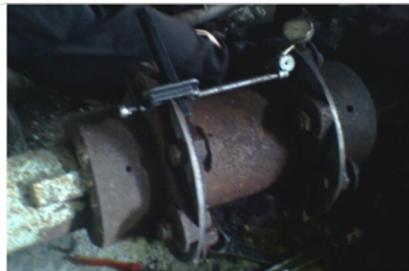
Gambar 4.14 Alignment pada Centrifugal Pump
