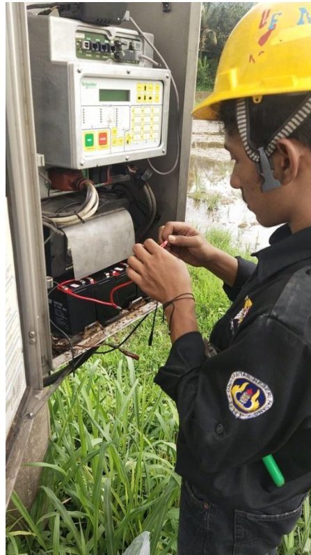
Gambar 5. Kegiatan Pemeliharaan Recloser PT. PLN (persero) UP3 Bogor
