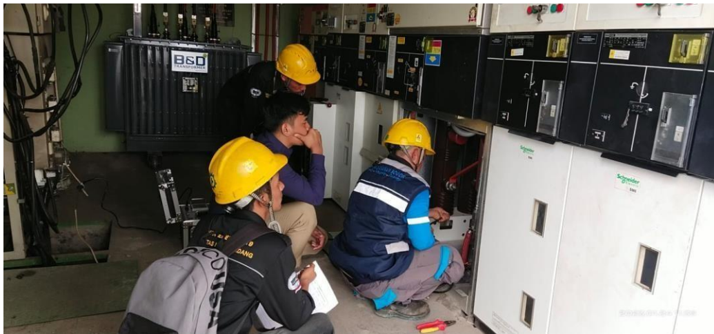
Lampiran 6. Mendeteksi Gangguan Jaringan Bawah Tanah
