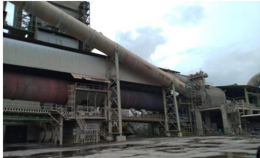
Gambar 8. Kiln Pabrik Indarung VI (Sumber : Dokumentasi Pribadi, 2023)
