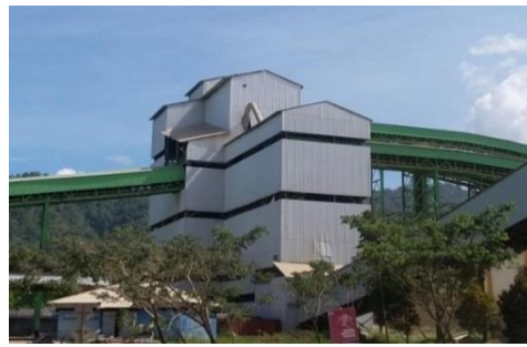
Gambar 6. Raw Feed Pabrik Indarung VI (Sumber : Dokumentasi pribadi, 2023)
