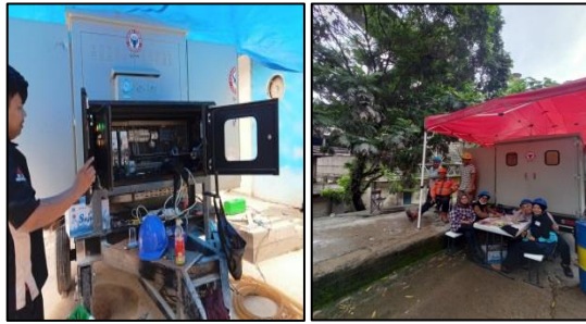
Gambar 19. Proses Purifikasi Trafo (Sumber : Dokumentasi Pribadi, 2023)
