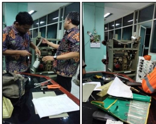
Gambar 18. Perbaikan OCB (Sumber : Dokumentasi Pribadi, 2023)
