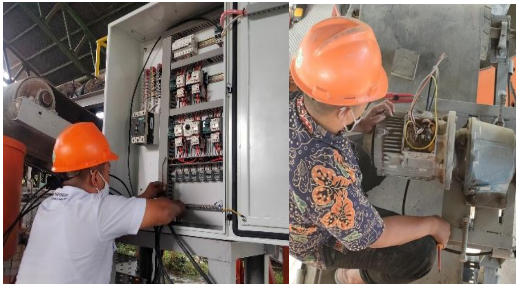
Gambar 4.6 Proses Terminasi pada Panel dan Motor
