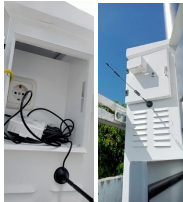
Gambar 4.13 Pemasangan Antena Pada Panel Box
