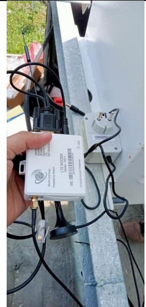
Gambar 12. Pemasangan Modem Wasion Pada Pelanggan 3 Fasa di Sungai Limau
