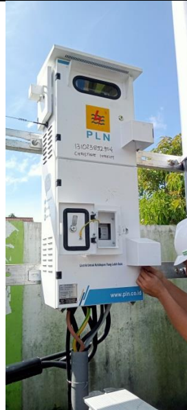
Gambar 10. Pemasangan Segel PLN Pada Panel Box yang telah terpasangan kWh Meter
