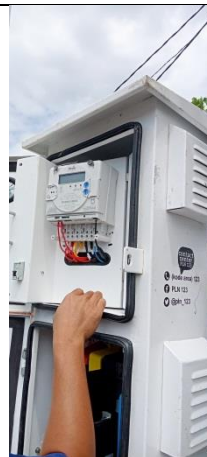
Gambar 15. Pemasangan kWh Meter 3 Fasa di PT Sarana Mitra Saudara
