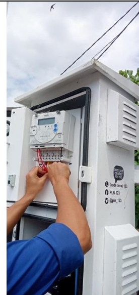
Gambar 4. Pemasangan kWh Meter 3 Fasa Di Christine Hakim Idea Park
