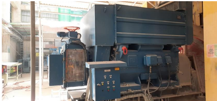
Gambar 32 Motor Induksi 6000 V (sumber : PT. Semen Padang)
