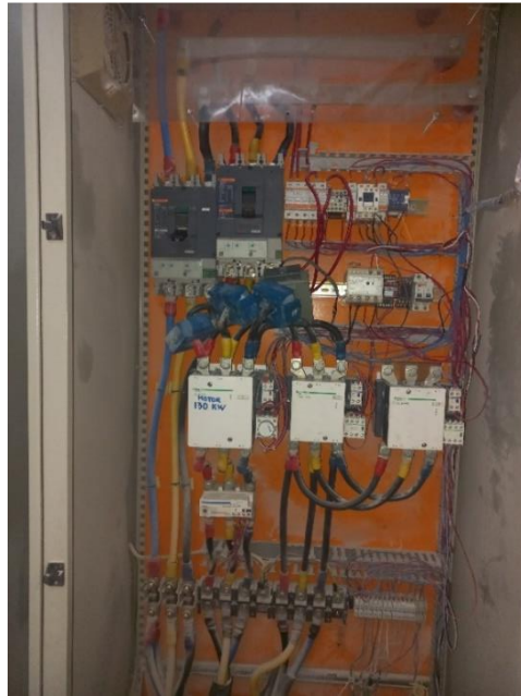
Gambar 28 Start bintang delta (sumber : PT. Semen Padang)
