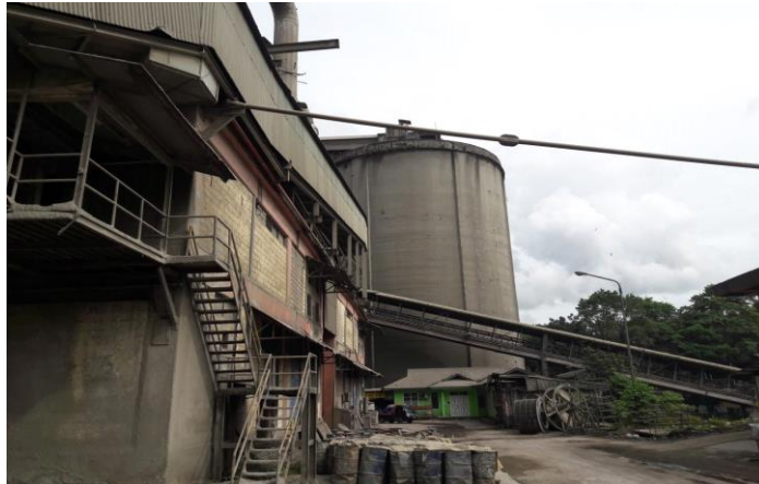
Gambar 16 Silo klinker (sumber: PT. Semen padang)
