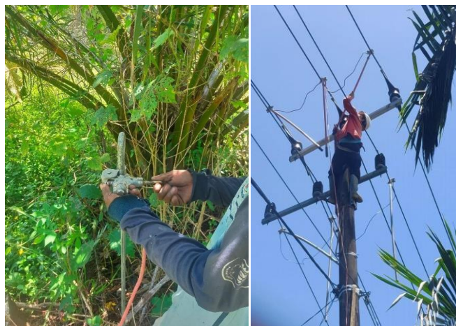
Gambar 28. Melakukan Grounding dan Pentanahan.
