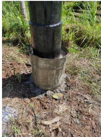
Gambar 32. Pengecoran Pada Tiang Kontruksi
