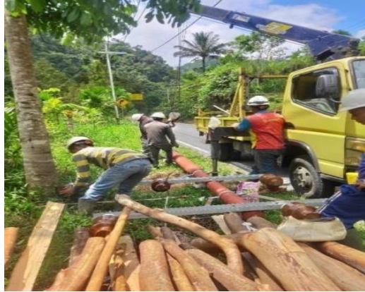
Gambar 30. Memasang Material Pada Tiang
