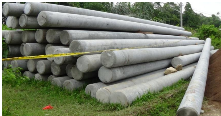
Gambar 4. Tiang Listrik Beton
