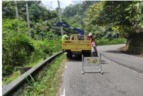
Gambar 26. Memasang Rambu K3
