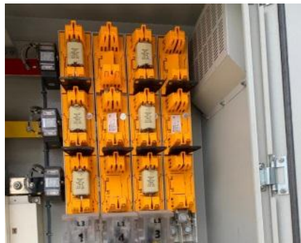
Gambar 8. NH fuse atau sekring (Sumber : Dokumentasi pribadi)
