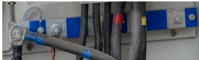
Gambar 6 busbar atau saluran pembagian
