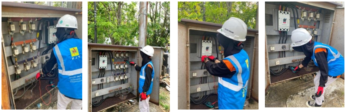
Gambar 15 Pemeliharaan PHB-TR (Perangkat Hubung Bagi Tegangan Rendah)
