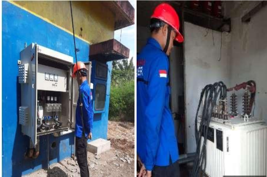
Lampiran 7 Pemeliharaan Gardu Beton
