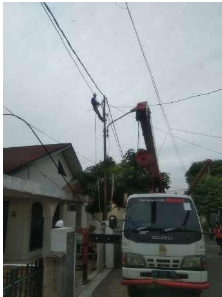
Gambar 3.4 Kegiatan penggantian kabel JTR
