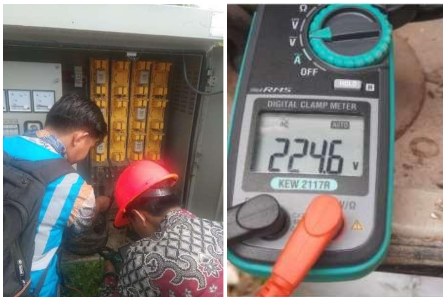
Lampiran 2 Pengukuran tagangan pada PHB TR
