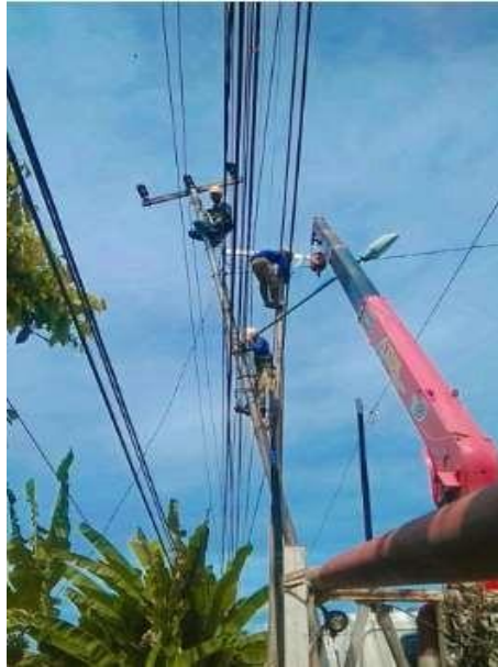
Gambar 3.2 Penggantian tiang JTM
