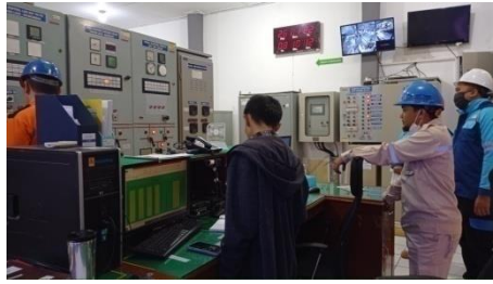
Gambar 8. Proses Manuver Pembebasan Tegangan PHT Payakumbuh 1
