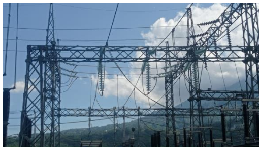
Gambar 10. Rel Daya (Bus Bar)
