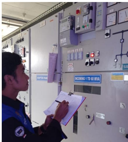
Gambar 3. Pencatatan Beban Penghantar di Ruang Kubikel
