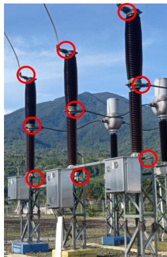
Gambar 20. Terminal Pengujian Tahanan Isolasi
