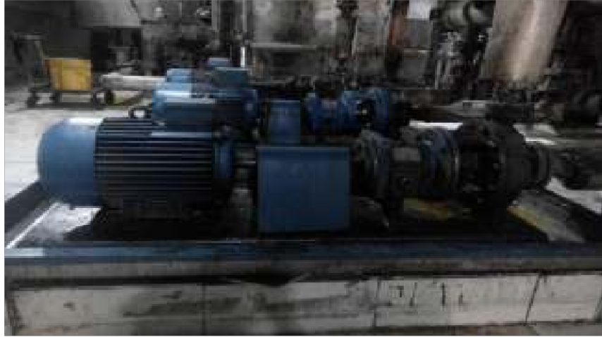
Gambar 3.3 Pompa Sentrifugal
