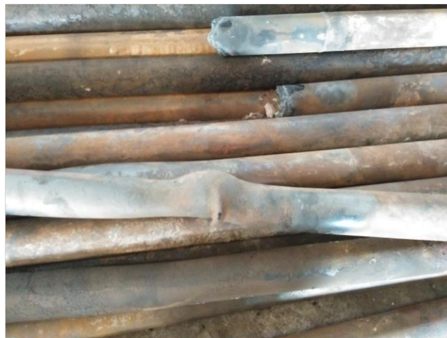
Gambar 31. Pipa Steam Mengalami Kerusakan Sumber PT Jaya Sentrikon Indonesia
