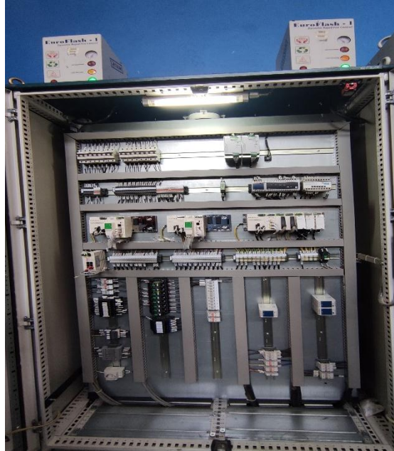
Gambar 38. Panel AVR PLTA Batang Agam
