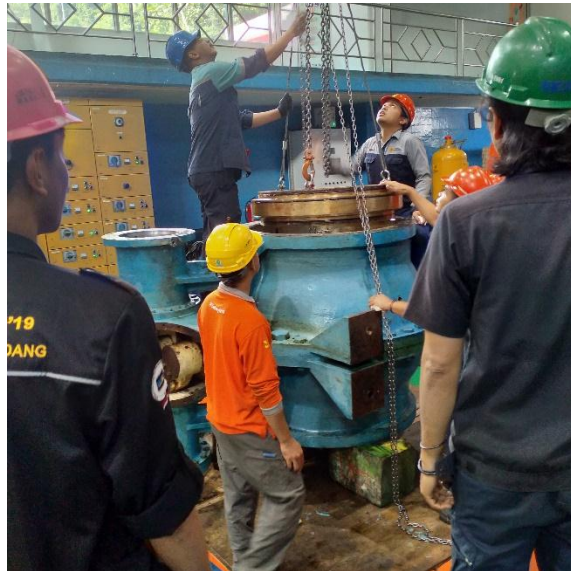
Gambar 26. Penggantian Seat ring
