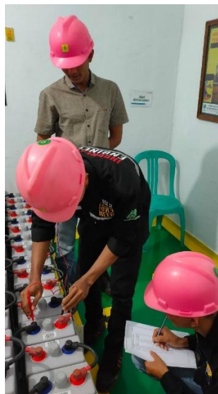
Gambar 28. Pemeliharaan Baterai (Sumber: PLTA Batang Agam )
