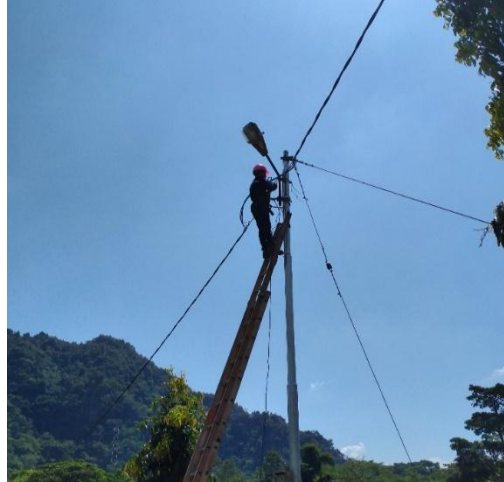
Gambar 29. Pemasangan Photocell
