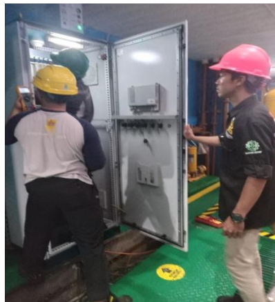
Gambar 25. Pemeliharaan Panel AVR
