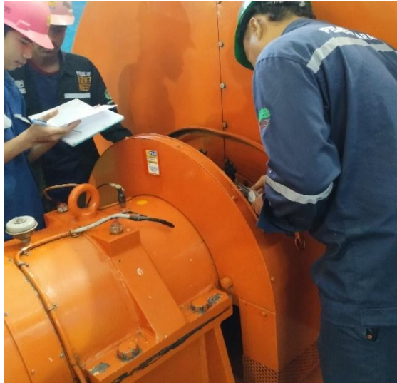
Gambar 24. Pemeliharaan Carbon Brush
