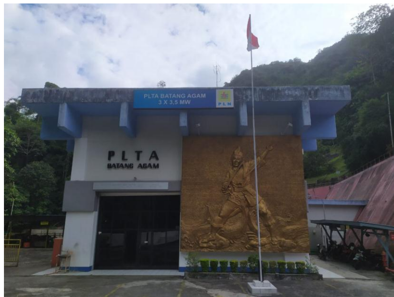
Gambar 1. Gedung PLTA Batang Agam
