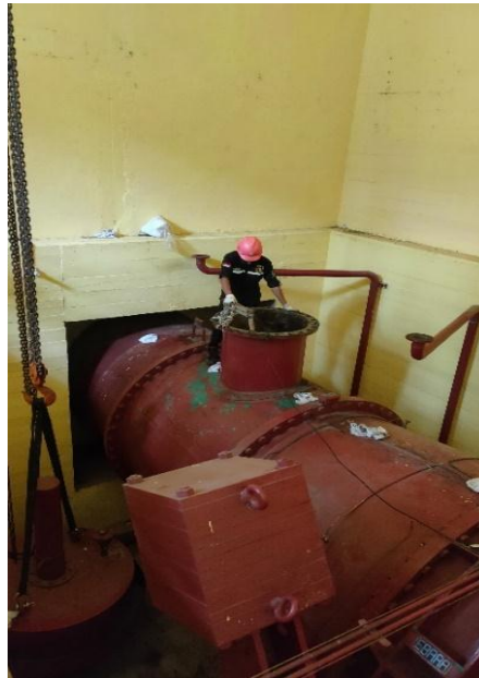
Gambar 31. Pemeliharaan Valve Chamber
