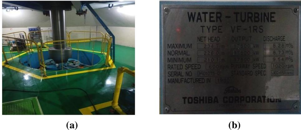
Gambar 1. 13 Turbin PLTA Maninjau (a) Bentuk Fisik, (b) Spesifikasi
