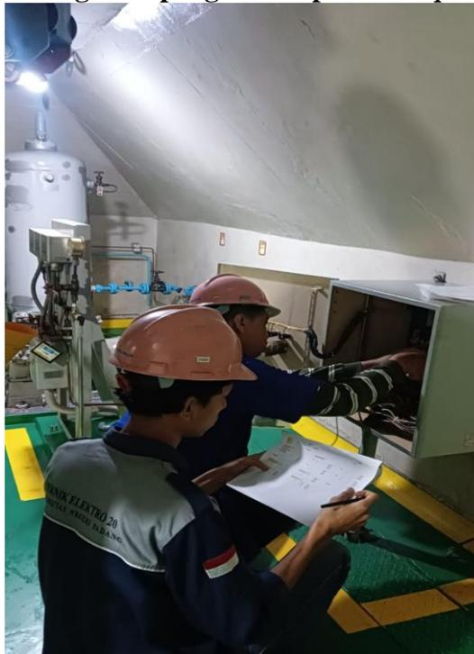
**Gambar 2. 26 Pengecekan pada *Kompresor***
