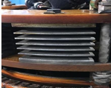
**Gambar 2. 16 Dioda Sistem Eksitasi**
