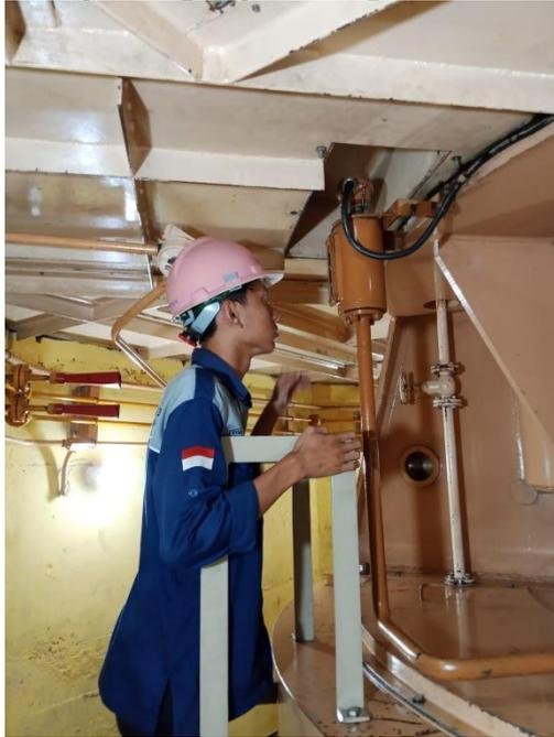
**Gambar 2. 23 Pengecekan pada oli *bearing***
