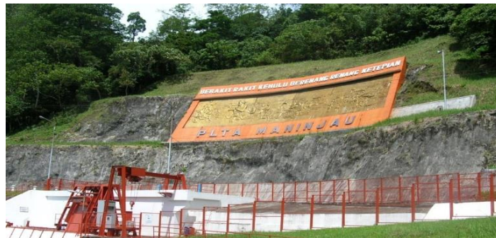
Gambar 2.3. Pintu Air Masuk ( Intake ) PLTA Maninjau
