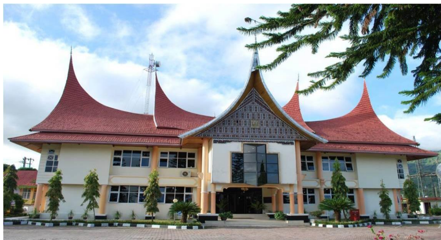
Gambar 2.1. Gedung Sektor Pembangkitan Bukittinggi (SBKT)
