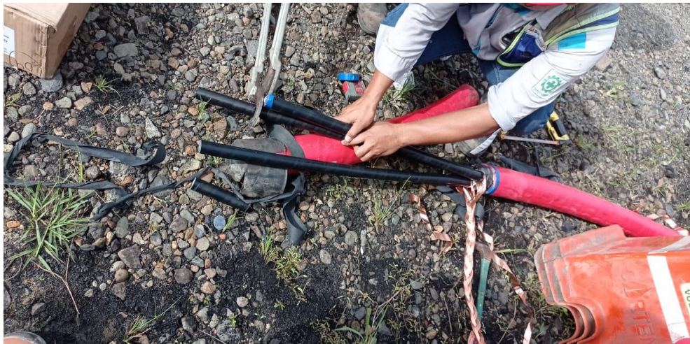
Jointing/Penyambungan Kabel 20 KV
