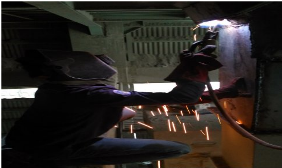
Gambar : Pengelasan Chute penampung klinker
