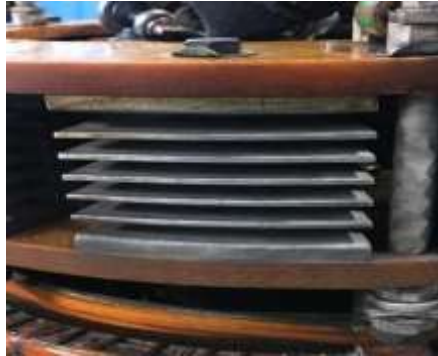
Gambar 2. 16 Dioda Sistem Eksitasi
