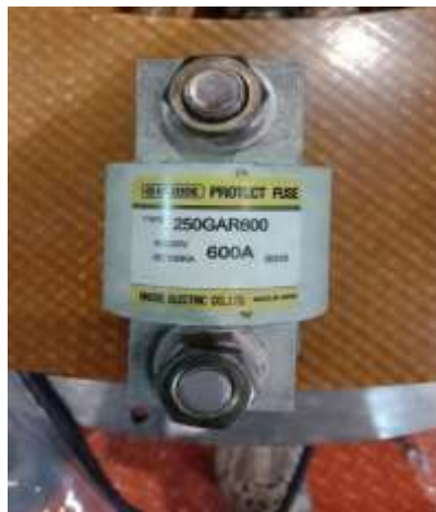
Gambar 2. 17 Fuse Sistem Eksitasi
