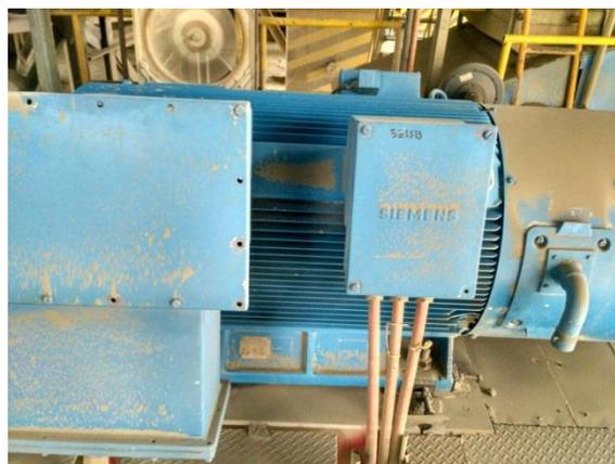
Gambar 17: Motor Penggerak *Fan Separator*
