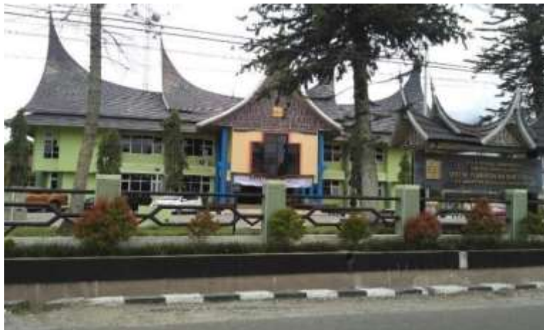
Gambar 1.2 Gedung Bukittinggi (UPK) (Sumber: PLTA Maninjau)
