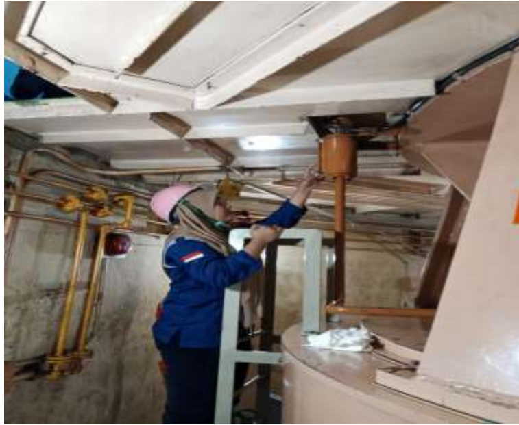
Gambar 2.12 Pengecekan Oli bearing
