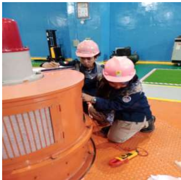
Gambar 2.10 Proses Pengecekan rotot
