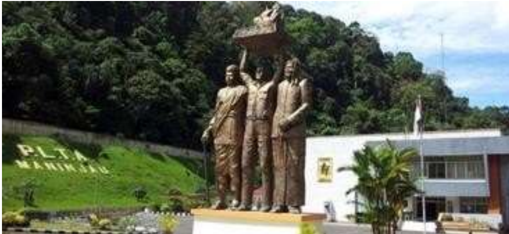
Gambar 1.12 Gedung Pembangkitan (Sumber: PLTA Maninjau)
