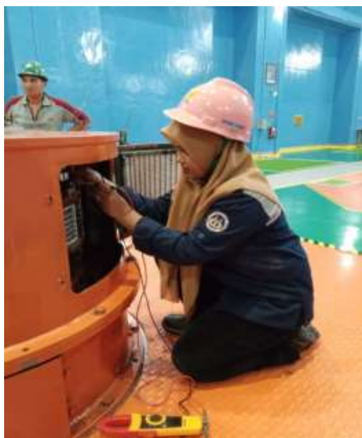
Foto Kegiatan pengecekan fuse generator minggu kedua
