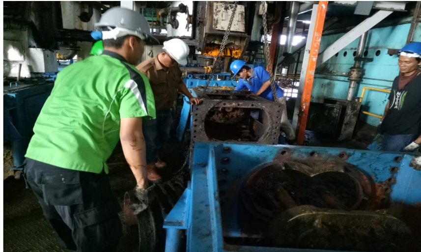
Gambar 4. Penggantian Screw Press dan Filter Cage
