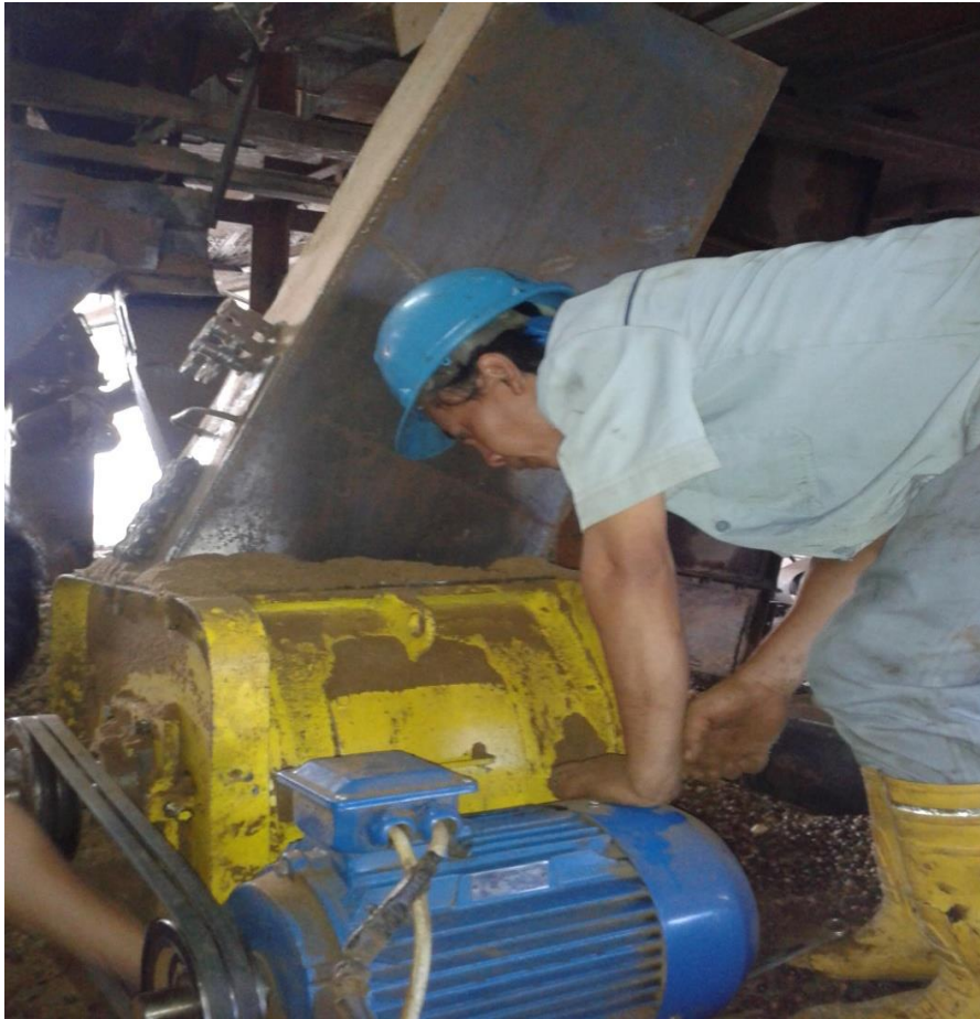
Gambar 9: Pembongkaran mesin ripple mill
