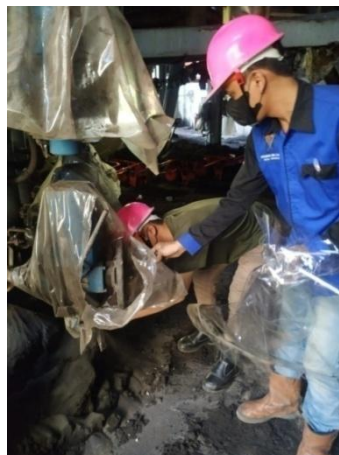
Gambar 4. Proses mengganti plastik pelindung katup
