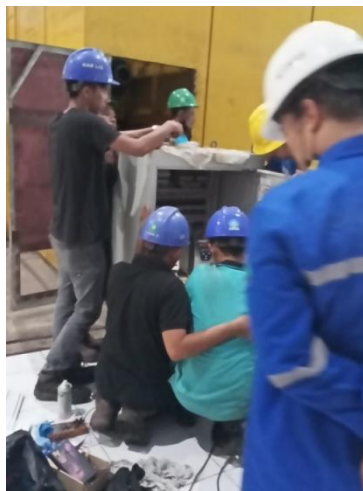
Gambar 6. Proses mengganti sekring pada panel turbin
