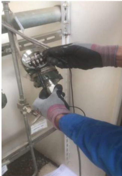
Gambar 25. Pemasangan Hand Pump
