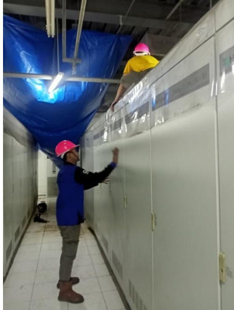
Melakukan cleaning pada relay room
