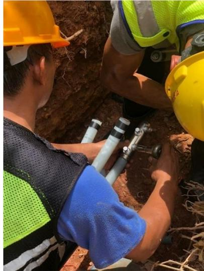
Gambar 2.12 Proses jointing core menggunakan Shear Bolt Connector
