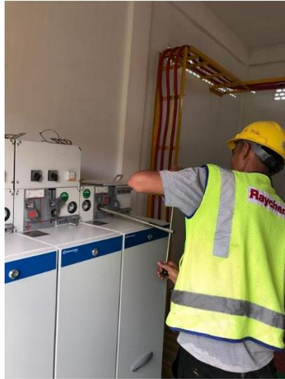
Gambar 2.19 Proses Energize / Normalisasi Tegangan
