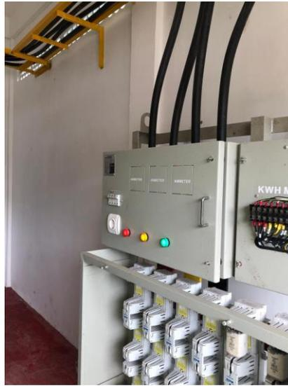
Gambar 2.21 Tampak Listrik Yang Sudah Tersambung di PHB-TR
