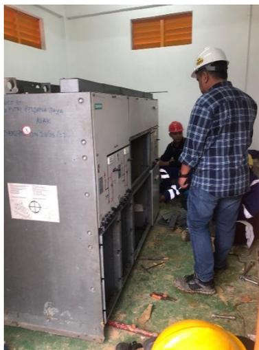
Gambar 1.18 Proses Pemasangan Kubikel 20kV
