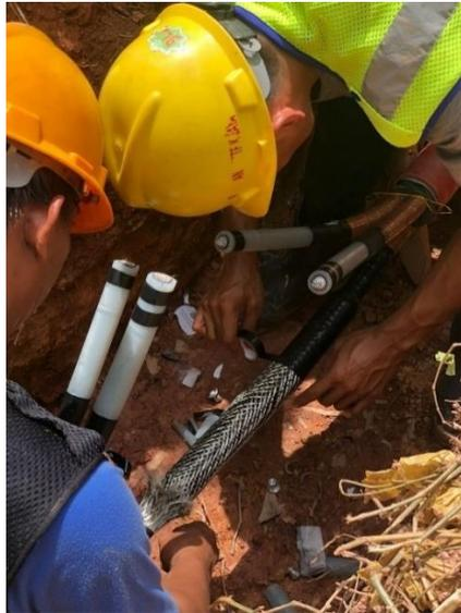
Gambar 2.15 Proses pemasangan Roll Spring pada Joint Body
