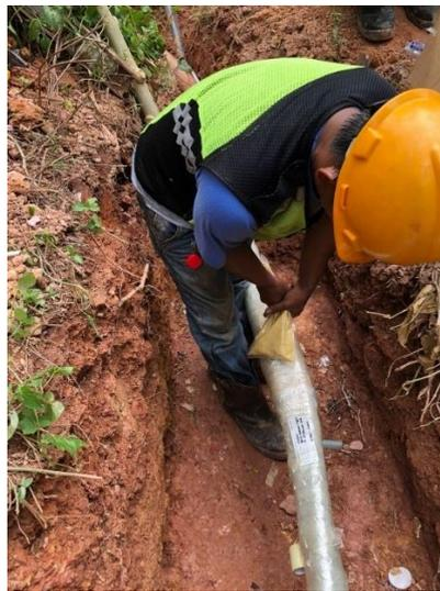
Gambar 2.17 Proses memasukan resin kabel
