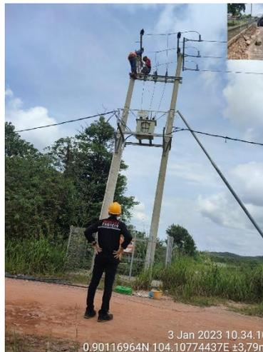
Gambar 1.15 Proses Pemasangan Kabel SUTM 20kV
