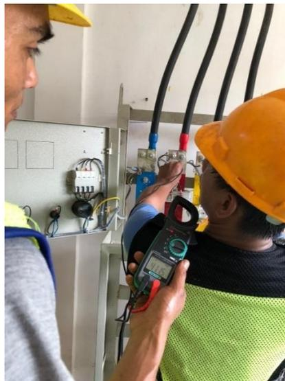
Gambar 2.20 Proses Pengecekan Fasa dan Grounding pada PHB-TR
