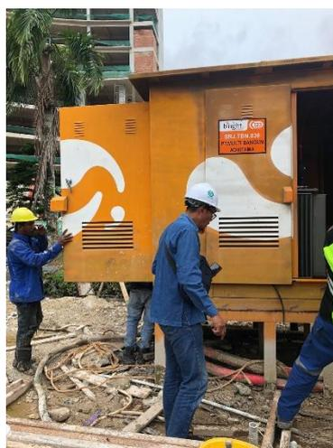
Gambar 1.16 Proses Relokasi Gardu Portable
