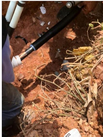
Gambar 2.14 Proses pemasangan joint body kabel SKTM
