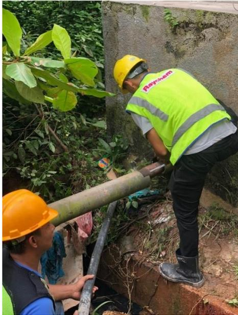
Gambar 2.8 Proses pemotongan pipa besi pada jalur kedua
