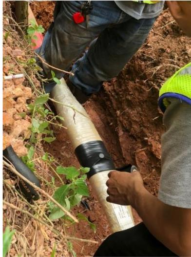
Gambar 2.18 Proses menutup lubang resin
