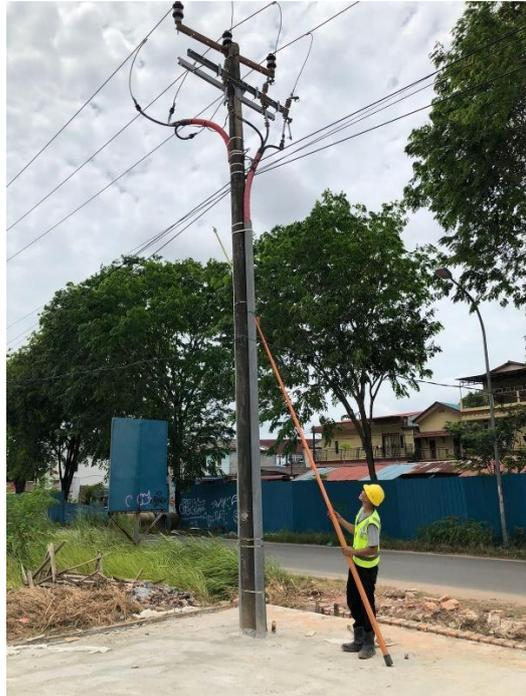
Gambar 2.4 Proses Pelepasan FCO pada Tiang SUTM
