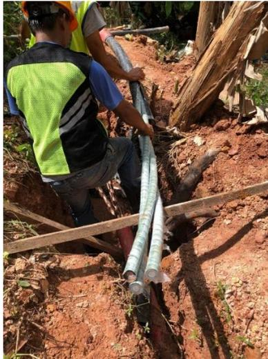
Gambar 2.10 Proses pemotongan kabel SKTM kedua
