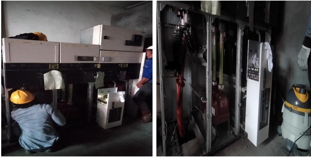
Gambar 16. Pemeliharaan Gardu Hubung
