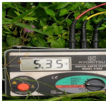
Gambar 12. Pengukuran tahanan pentanahan
