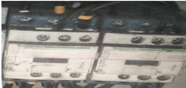
Gambar 3.14. kontaktor maju mundur hoist crane.
