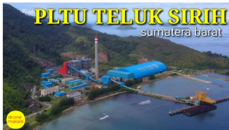
Gambar 1. Tampak Keseluruhan Wilayah PLTU TELUK SIRIH
