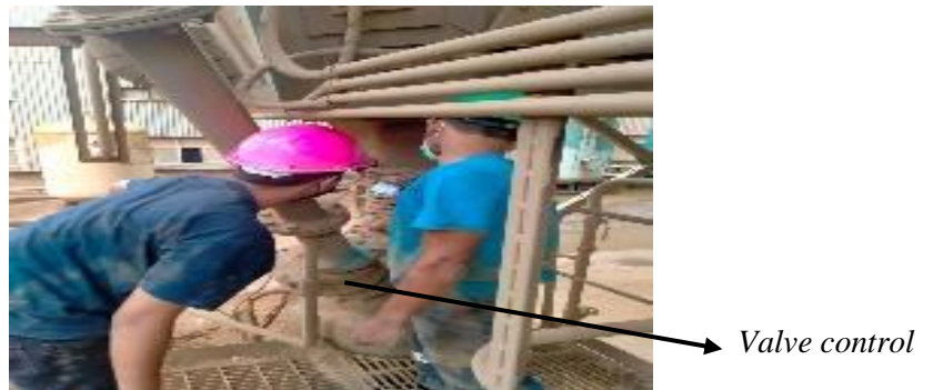
Gambar 13. Proses Perbaikan Valve control yang bocor
