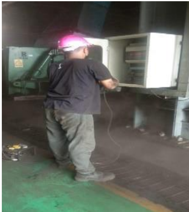
b. Kegiatan Cleaning pada panel Crusher batu bara
