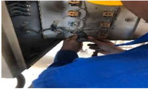
Gambar 3. Kegiatan penggantian connector pada valve kontrol ( Sumber : Pribadi )
